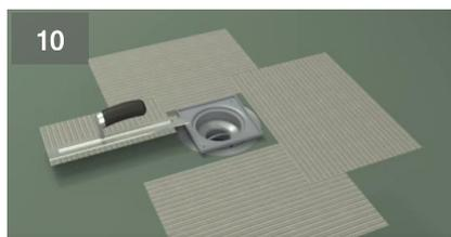
10 После того, как герметик высохнет, установите карьер решетки в стакан слива. Затем нанесите слой клея под плитку. Важно: Фильтр отверстия не должен быть запечатан гидроизоляционным поверхностным герметиком или плиточным клеем.
