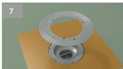
7 Вставьте изолирующий воротник в жидкий гидроизоляционный герметик.
