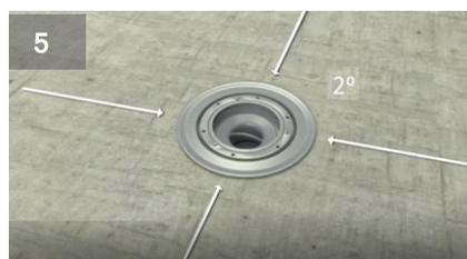
5 Выполните стяжку пола. Уклон пола не менее 2 градусов к трапу. Сохраняйте фланец для гидроизоляции чистым.
