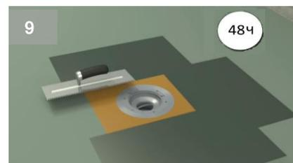
9 Нанесите второй слой гидроизоляционного поверхностного герметика. Минимальное время для высыхания второго слоя - 12 часов, оптимальное - 48 часов.
